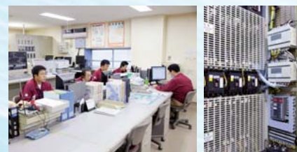
H-NETで収集されたデータは中央監視室で一元管理
