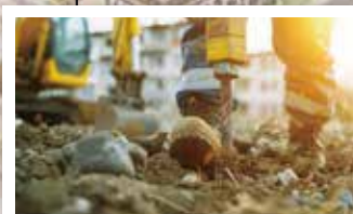
建設現場 エアーツール
