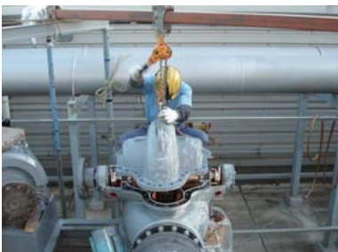
ポンプ：点検・整備
